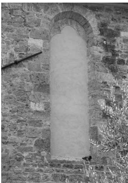
Fig. 4. Finestrone ad arco a tutto sesto trilobato individuabile nel perimetrale settentrionale della chiesa
