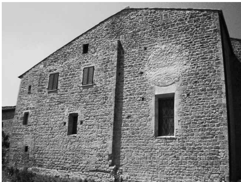
Fig. 2. Veduta esterna della parte absidale della chiesa. Resti del finestrone originale e del successivo occhio in mattoni (oggi tamponato). La porzione muraria sporgente è relativa all'ambiente della sacrestia
